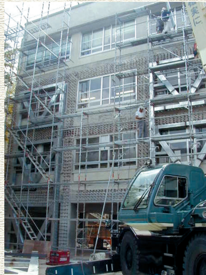
避難所(学校等)の耐震改修
