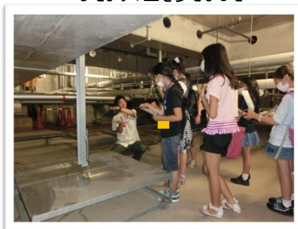
① 地下にある免震構造などを見学しました
