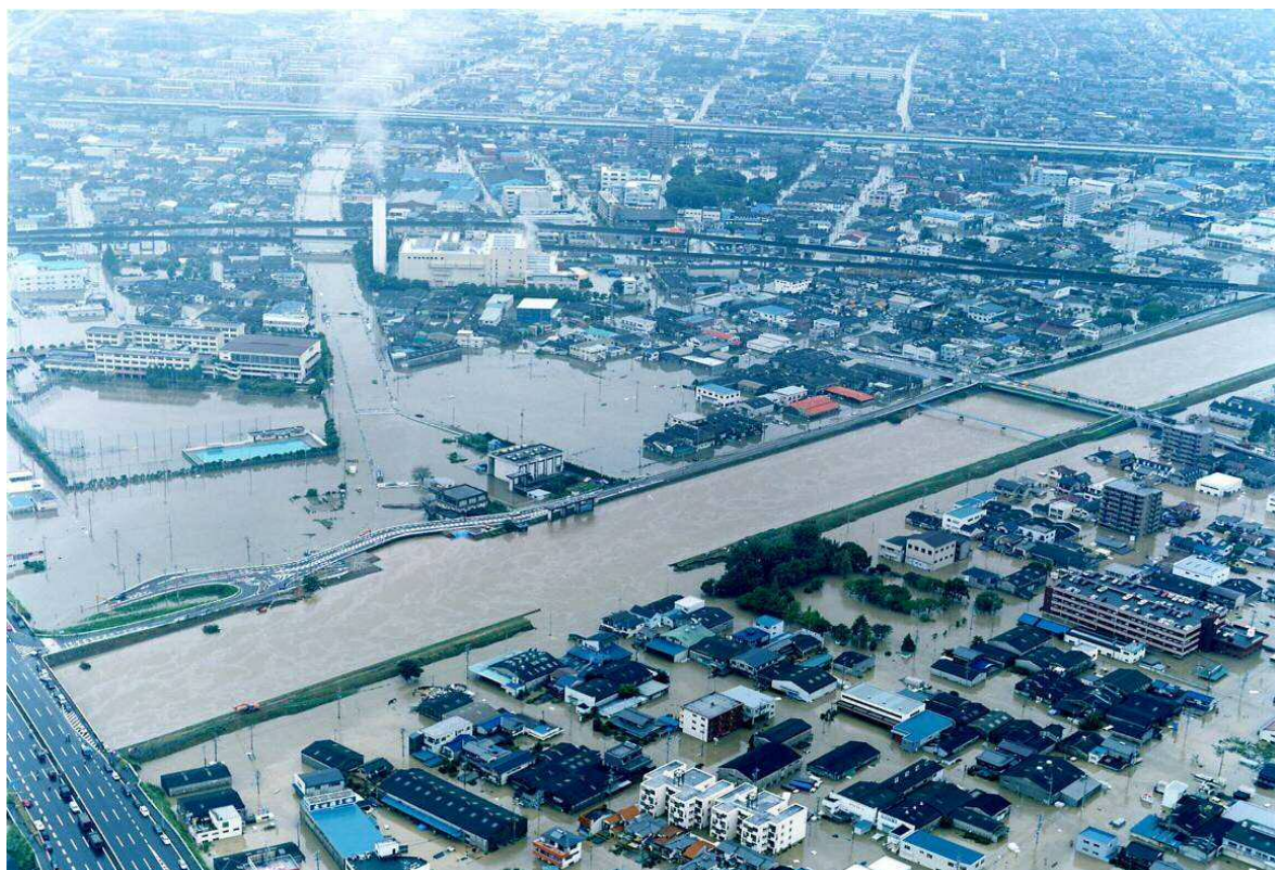
平成12年9月12日(東海豪雨) 新川新橋上流 新川破堤箇所
