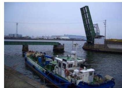
名古屋港跳上橋
