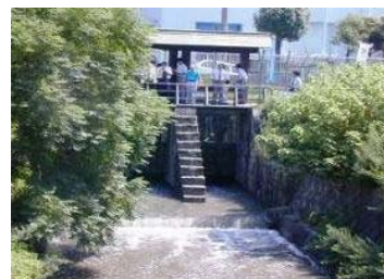
庄内川からの暫定導水
