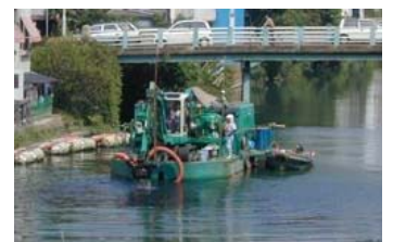
堀川環境整備事業(ヘドロ除去)
