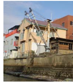
荷揚げ用クレーン
