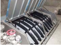
下水高度処理施設(名城水処理センター)
