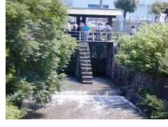
庄内川からの暫定導水
