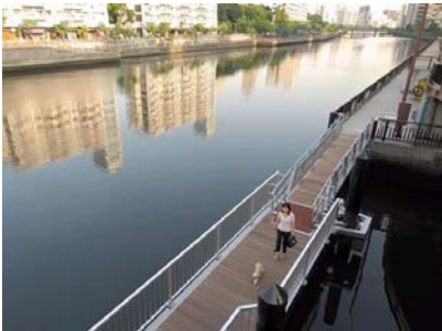
公共空間を活かした遊歩道の連続化の例（東京・天王洲運河）
