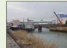
鉄道橋梁改築
