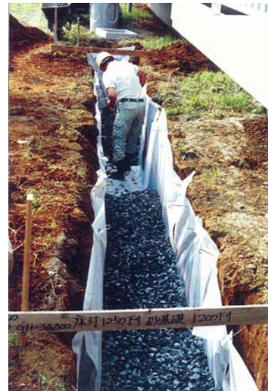
図 7-3 充填碎石の施工
