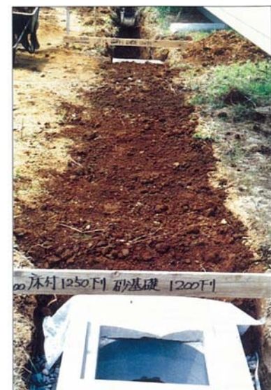
図 7-7 透水シート覆工後の
