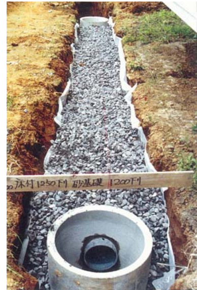
図 7-5 充填砕石工の完了
