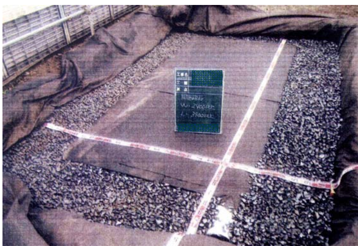
図 6-16 地下埋設部の出来形写真の例
