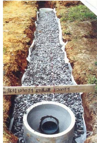
図 7-5 充填砕石工の完了
