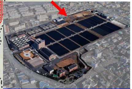
鍋屋上野浄水場
