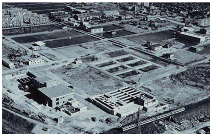
建設中の山崎東部下水処理場 （現鳴海水処理センター）
