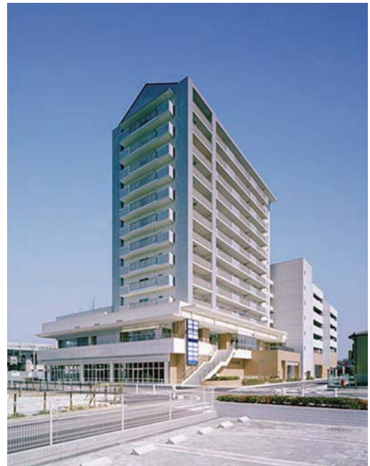
鳴海駅前再開発事業D工区（リベスタ鳴海）
