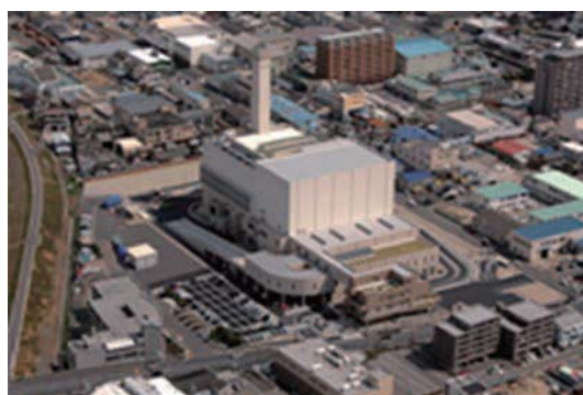
空から見た名古屋市鳴海工場
