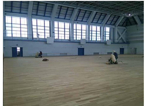
【図 2-4】体育館の床改修の様子
