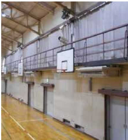
【体育館に設置されている空調設備の例】
