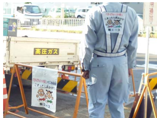
子どもに優しい工事現場
