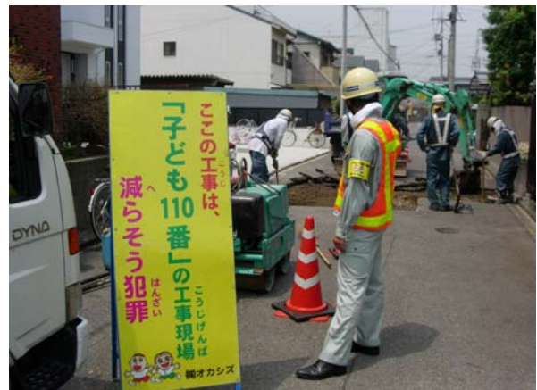
25/7 施工現場の地域の子供たちを守る
