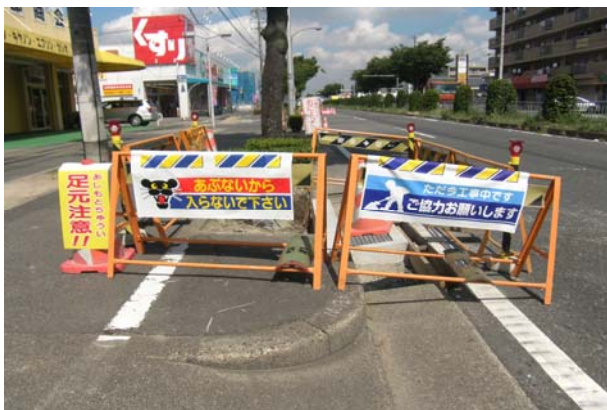
子どもに配慮した工事看板・標識
