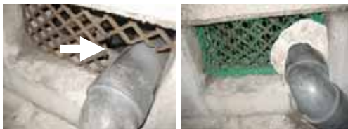
防そパテと亀甲金網で通気口の穴を塞いだ例
