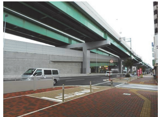
図 1 低層遮音壁の設置状況
