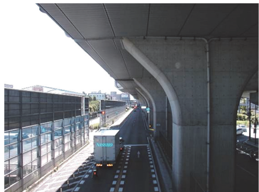
図 2 高層遮音壁の設置状況
