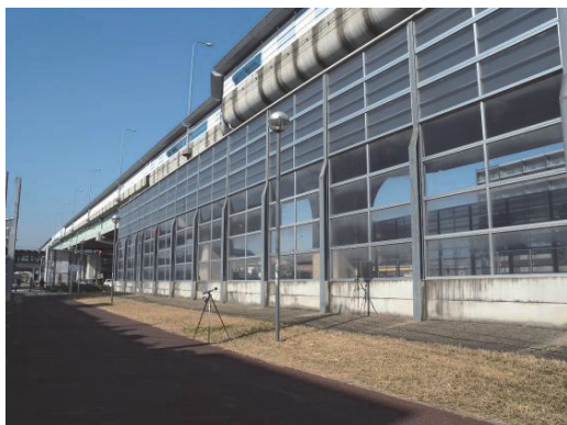
図6 高層遮音壁の測定地点状況
