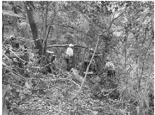
図14. エリアIV・大島造園前北西側の谷筋の保全作業
