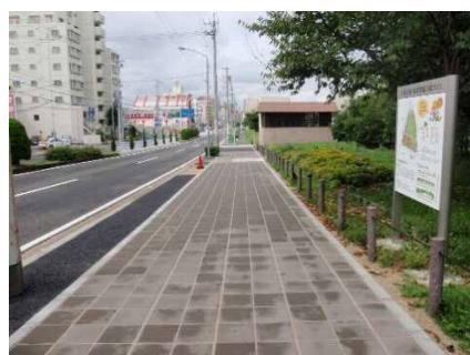
B 保水性ブロック舗装
