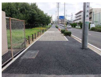
C 透水性アスファルト舗装
