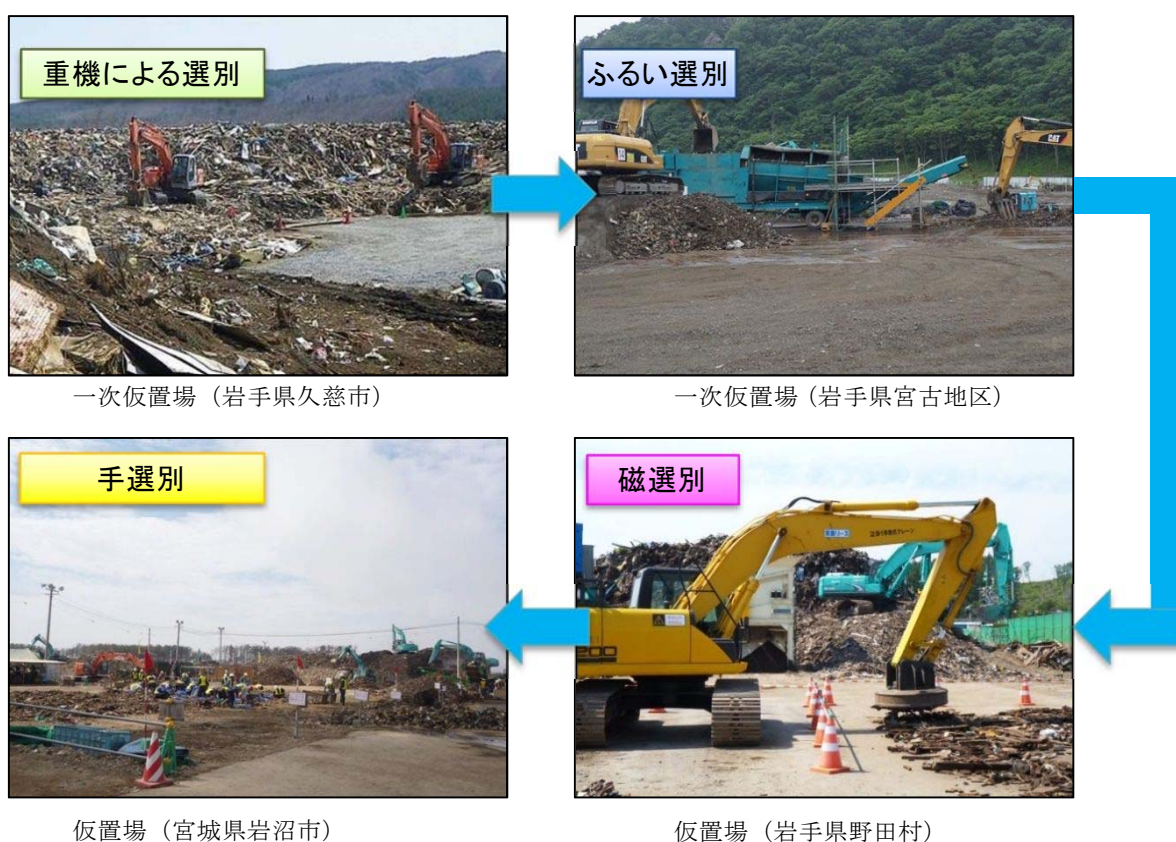
図 2.2.5 一次仮置場における粗選別の例
