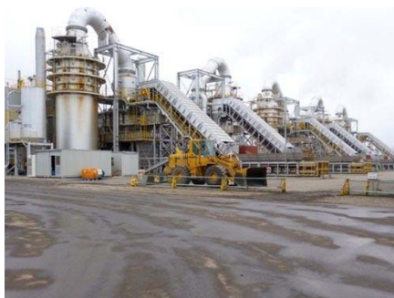
写真 2.2.2 仮設焼却炉
