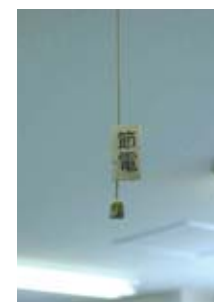
エコ事業所の事例 照明器具一つずつに 手動スイッチを付けている
