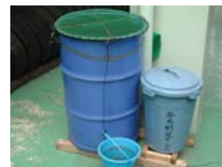
エコ事業所の事例 雨水貯留施設の設置(左ドラム缶、中タンク、右廃温水器)
