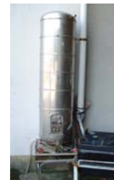
エコ事業所の事例 雨水貯留施設の設置(左ドラム缶、中タンク、右廃温水器)
