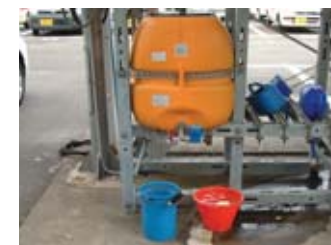
エコ事業所の事例 雨水貯留施設の設置(左ドラム缶、中タンク、右廃温水器)
