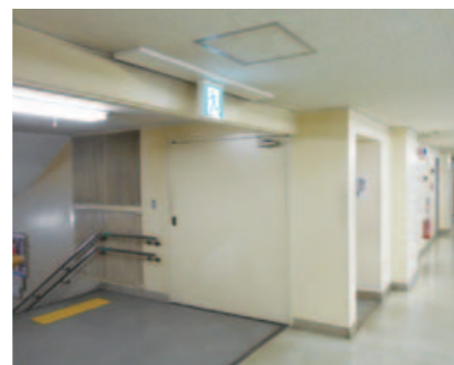
非常灯 (中村区役所)
