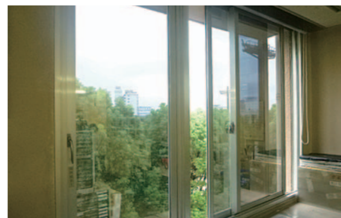
遮熱フィルムを貼った窓ガラス
