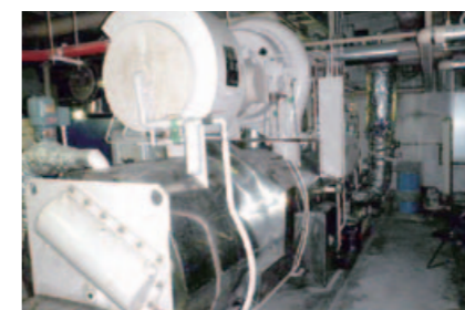
ターボ冷凍機
