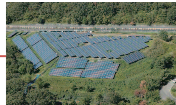
大清水処分場の太陽光発電設備
