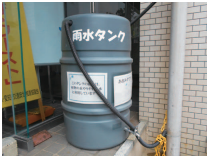
緑区役所に設置されている雨水タンク
