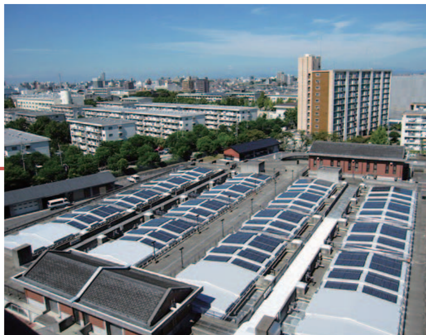
鍋屋上野浄水場の太陽光発電設備
