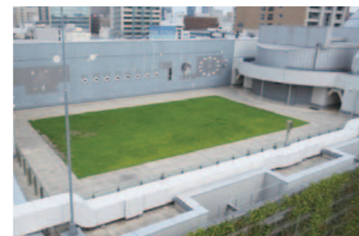
科学館の屋上緑化
