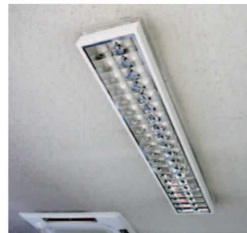
名東土木事務所の反射板ルーバー
