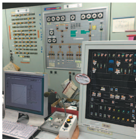
中央監視室でのデマンド監視
