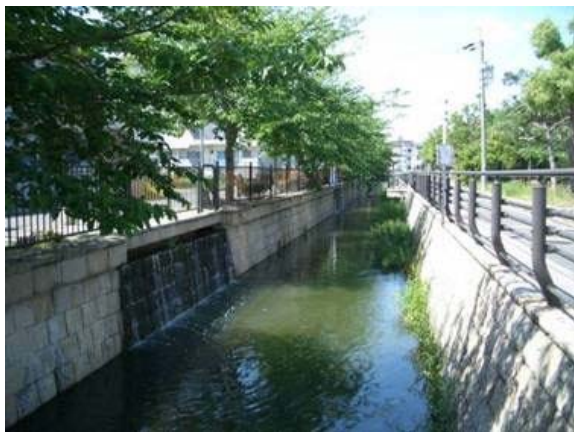
▲ 下水再生水を荒子川に導水
