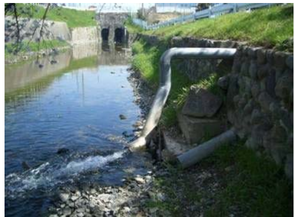
▲ 浅層地下水を堀川に導水
