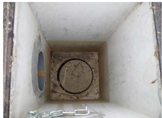
浸透ますの内部
