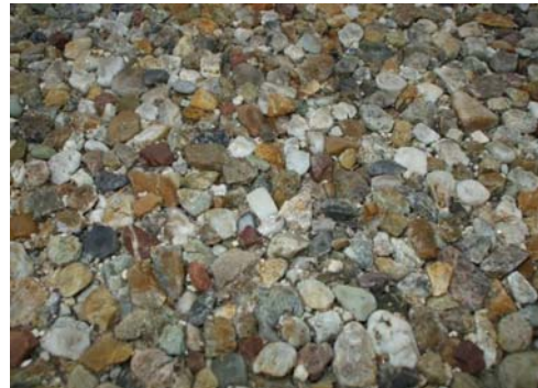
透水性舗装の表面
