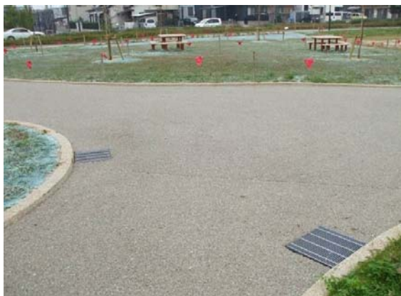
園路内に設置された浸透ます
