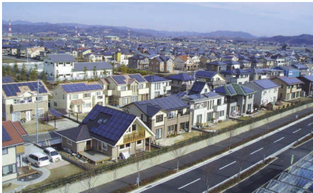
「太陽光発電システム実証試験地区(群馬県太田市 PalTown 城西の杜)」
