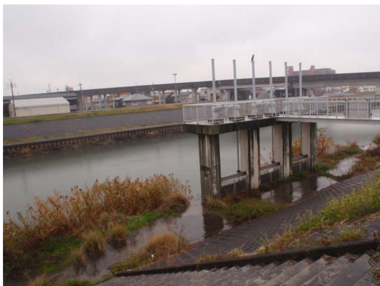
写真 7-4-2 放水口対岸の状況 (No. 2)
