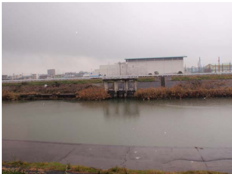
写真 7-4-1 放水口周辺の状況 (No. 1)
