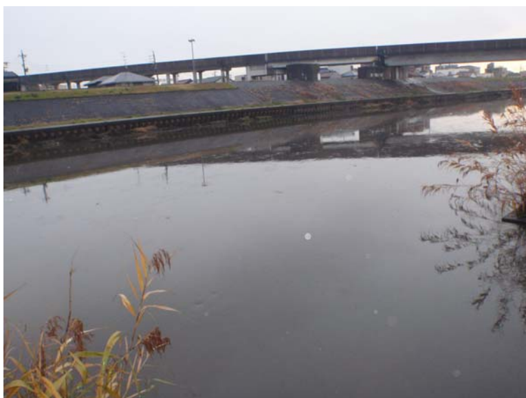
写真 7-4-3 放水口周辺の状況 (No. 3)
