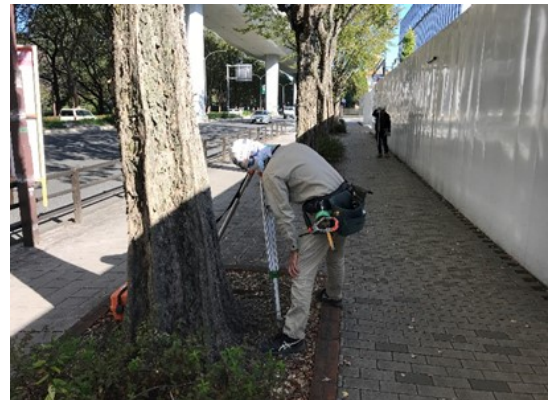
写真7-1-2-10 山留め材及び周辺地盤の計測管理
