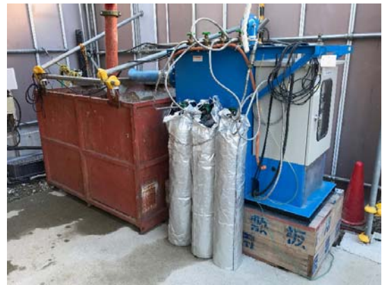
写真7-1-2-8 工事排水の適切な処理
