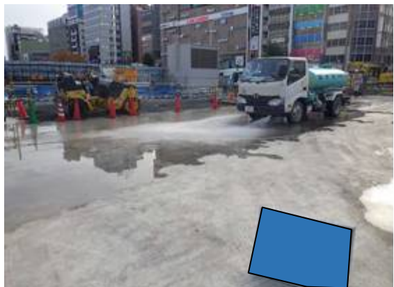
写真 7-1-3-5 工事現場の清掃、散水
