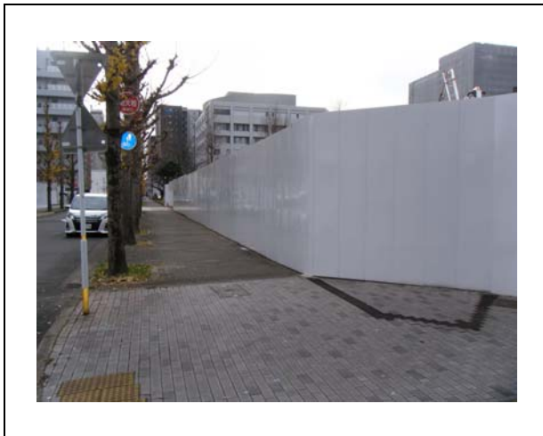
写真7-1-2-1 仮囲い等の設置
