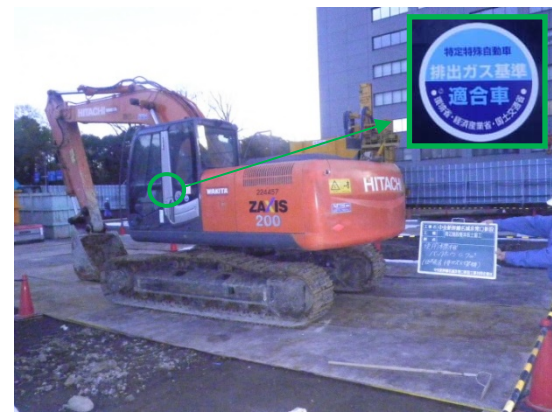
写真7-1-1-2 排出ガス対策型建設機械の採用
