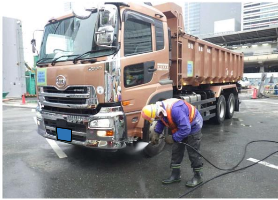
写真 7-1-3-7 資材及び機械の運搬に用いる車両の出入口、周辺道路の清掃及び散水、タイヤの洗浄
