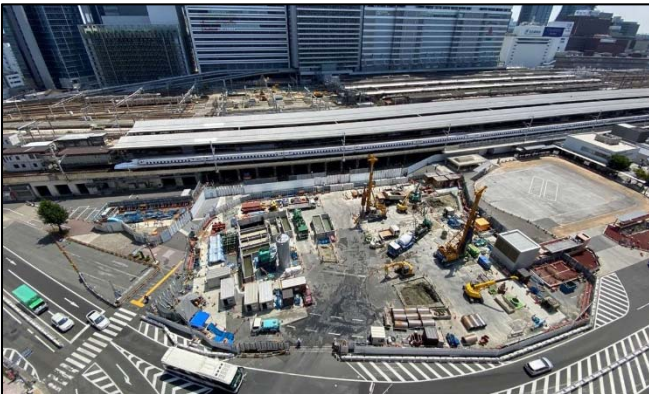
写真 3-2-3-1(5) 名古屋駅（中央工区全景）
