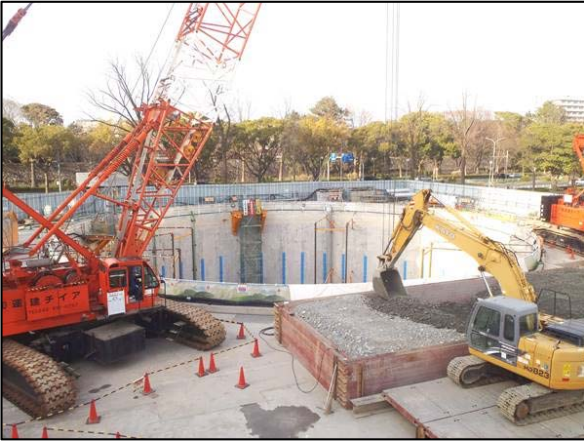
写真 3-2-3-1(1) 名城非常口（地上部）
