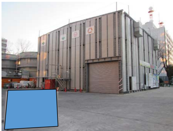
写真7-1-1-5 防音ハウスの設置
