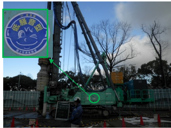
写真7-1-1-4 低騒音型建設機械の採用
