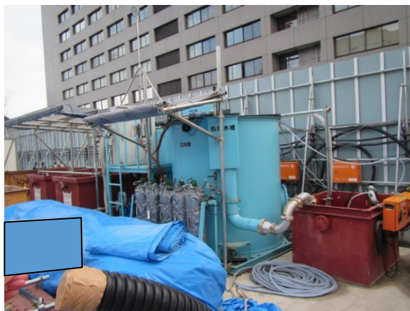
写真7-1-1-9 工事排水の適切な処理
