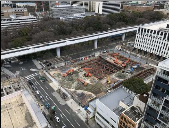
写真 3-2-3-1(3) 名城変電所（全景）
