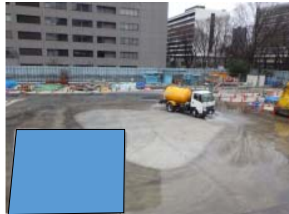
写真7-1-1-6 工事現場の清掃、散水
