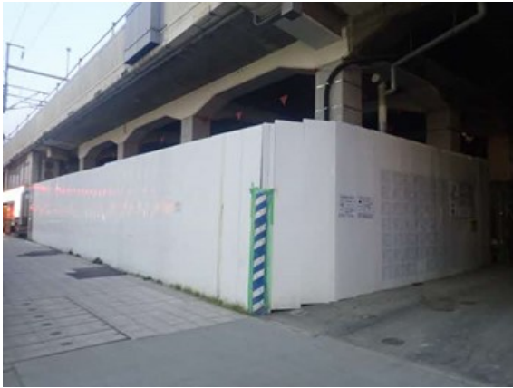
写真 7-1-3-1 仮囲い等の設置
