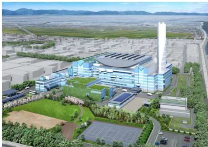
設備更新後の南陽工場 (イメージ)
