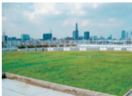
屋上緑化の様子
