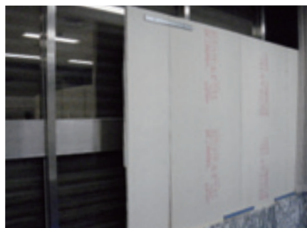
遮熱材設置の様子
