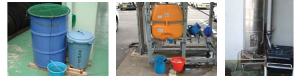
エコ事業所の事例 雨水貯留施設の設置(左ドラム缶、中タンク、右廃温水器)
