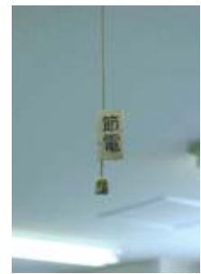
エコ事業所の事例 照明器具一つずつに 手動スイッチを付けている
