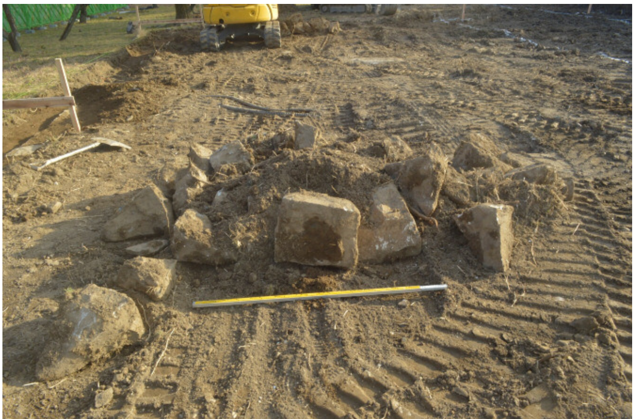
写真2 き損直後の石列石材状況／北から
