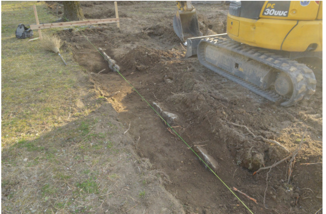
写真3 き損直後の石列残存状況／北東から
