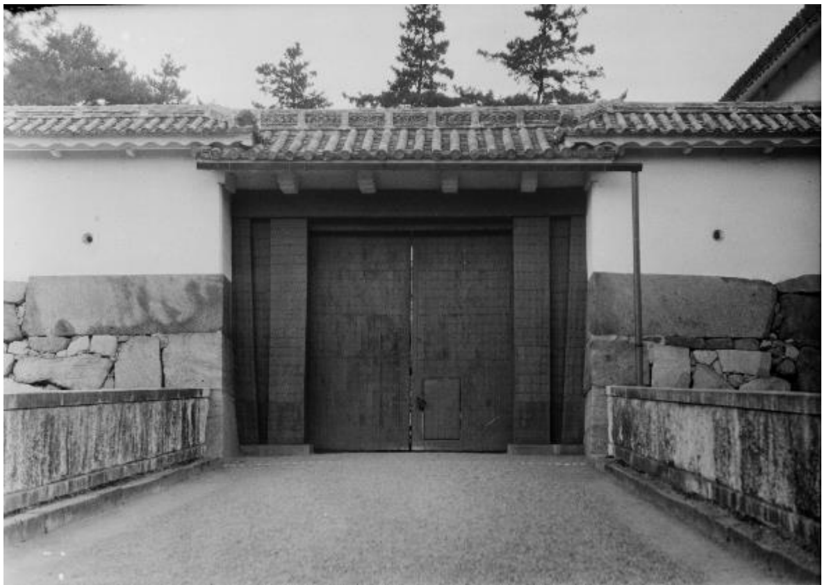
ガラス乾板写真 表二之門正面 昭和初期 名古屋城総合事務所蔵
