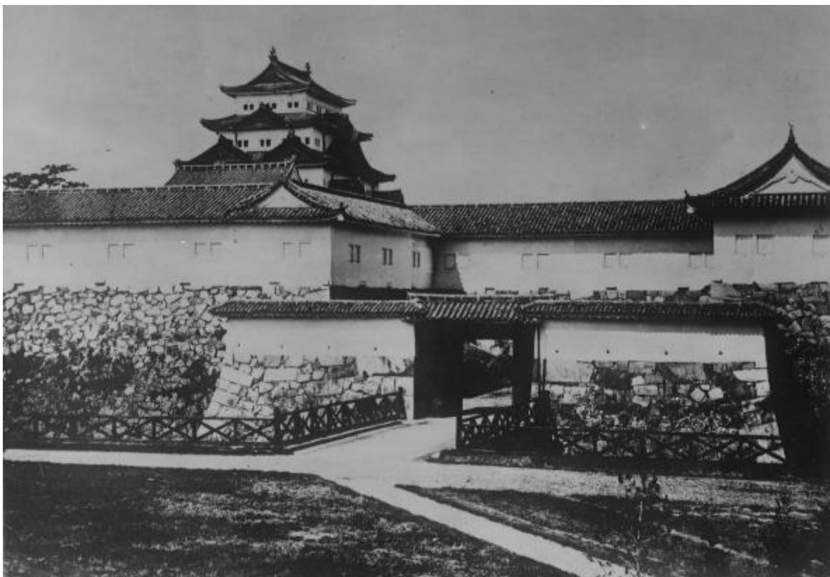
ガラス乾板写真 本丸南二の門 明治初期 名古屋城総合事務所蔵
