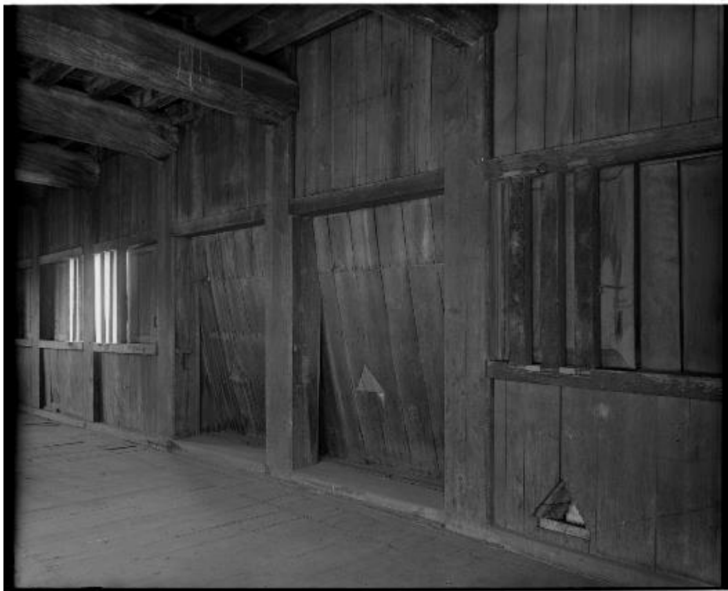
ガラス乾板写真 天守閣 1 階内橋台上南側石落及び鉄砲狭間（焼失） 昭和初期 名古屋城総合事務所蔵
