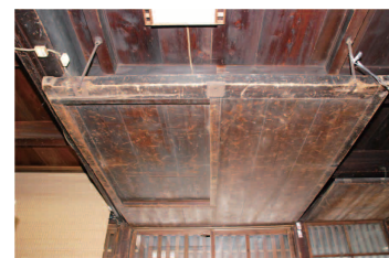
格子建具になる以前の吊り戸が残っている町家も
