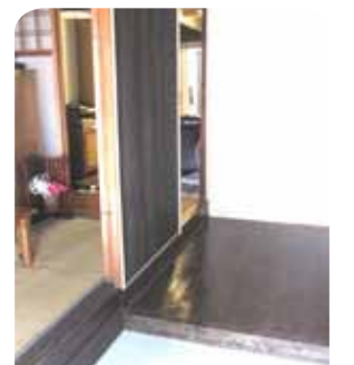
土間と居室との段差を緩和する板敷きを玄関に新たに設置しました。
