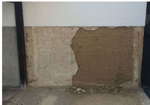
腰壁(洗い出し仕上げ)の剥落
