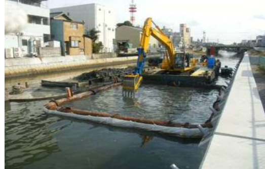
河道掘削状況写真
