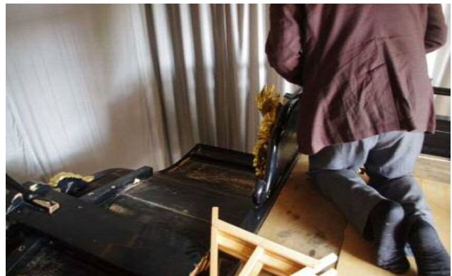
鳴海裏方高欄欠損箇所修繕方法指導
