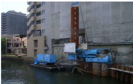
護岸整備状況写真
