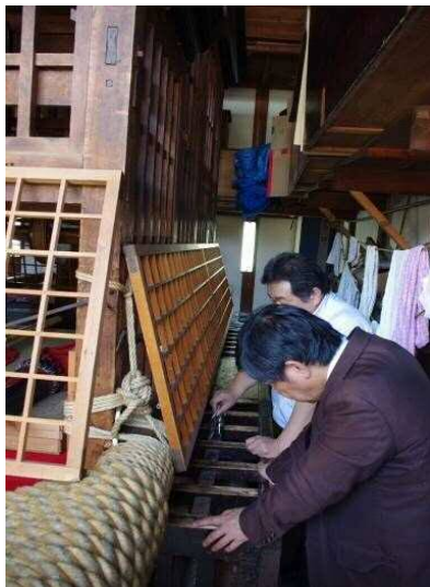
有松西町神功皇后車の車輪修繕修理前現地指
