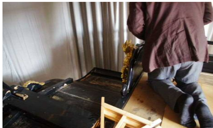
鳴海裏方高欄欠損箇所の修繕方法指導
