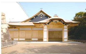
玄関・車寄(外観)
