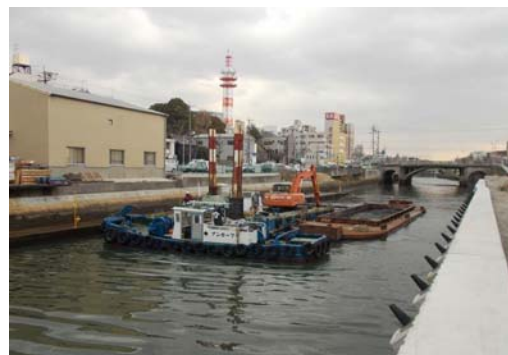
河道掘削状況写真
