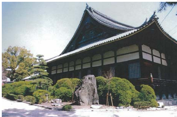
建中寺本堂屋根
