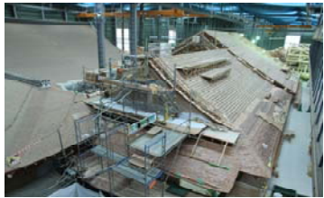
素屋根見学通路東側から
