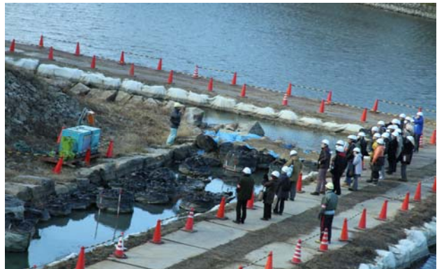
石垣修復現場見学会の様子
