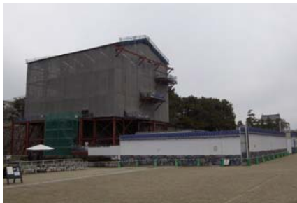
素屋根設置状況
