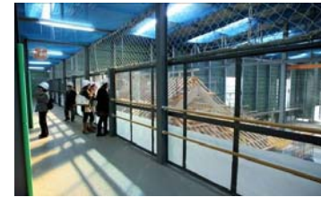
素屋根内部見学通路
