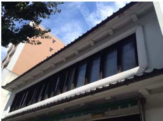
外壁漆喰の浮き、ひび割れ、剥離
