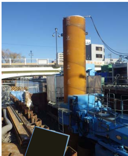
護岸整備状況写真
