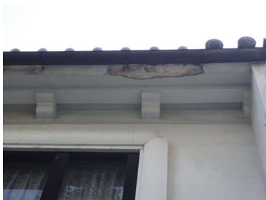
外壁漆喰の浮き、ひび割れ、剥離
