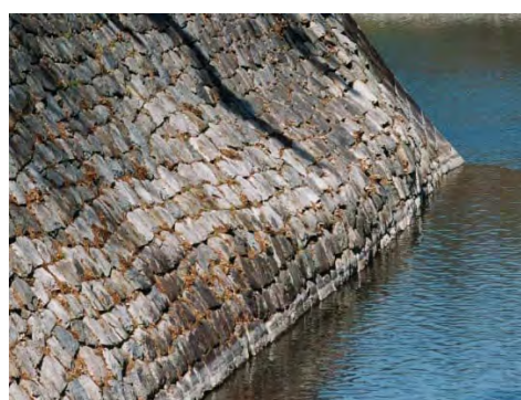
修復が必要な石垣
