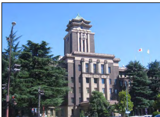
写真 1-20 名古屋市役所本庁舎
