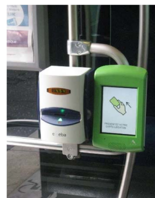
車内に設置された IC カード読取機と切符に使用日を印刷する機械
