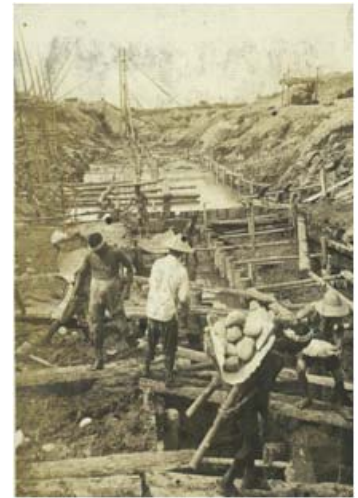
運河の開削状況
