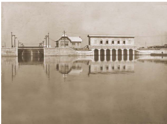
建設当時の中川口通船門(左)と放水門(右)
