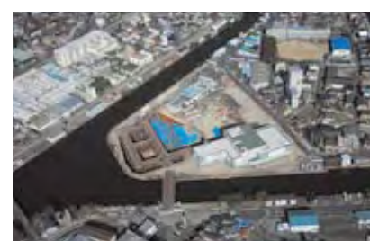
露橋水処理センター(建設中)
