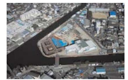
露橋水処理センター（建設中）
