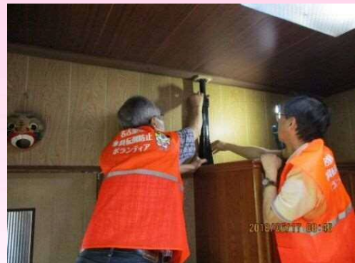
家具の転倒防止作業
