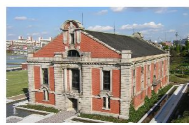
【鍋屋上野浄水場】
