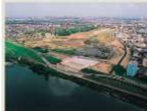
現在の洗濯の様子（庄内川河川事務所提供）
