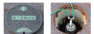
仮設給水栓も給水を確保するための設備です。災害時に上下水道局や協力企業が出動し、設置します。
