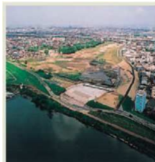
現在の洗堰の様子（庄内川河川事務所提供）
