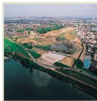
現在の洗濯の様子（庄内川河川事務所提供）
