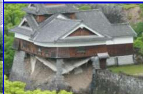
五階櫓の石垣崩壊と床の落下
